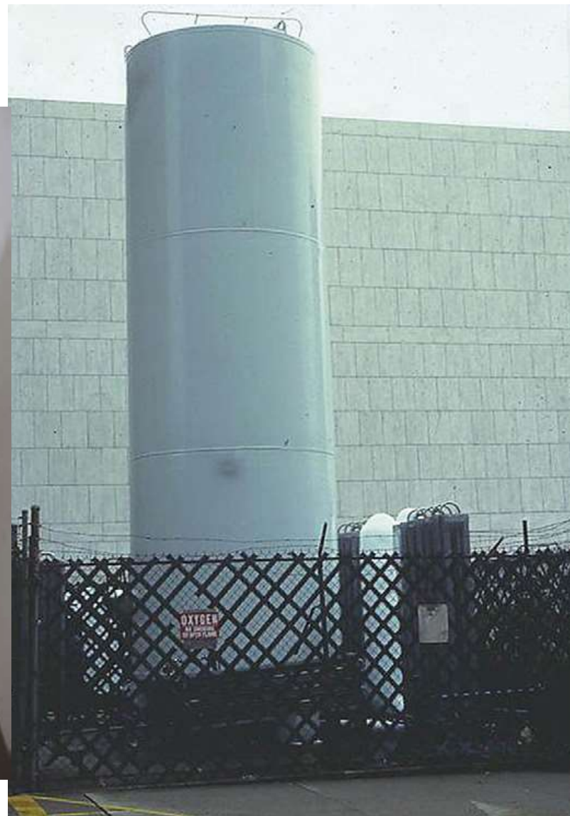
O 2 Formă lichidă Temp de fierbere -183grade C° ; 80.000 L Pres = 729 psig
